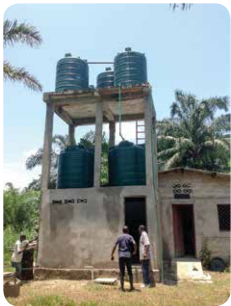
Il castello d'acqua alimentato a energia solare
